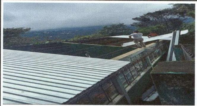
Foto 2: Lámina en mal estado, módulos de aula y cocina (28mts de largo y ancho 14 mts)
