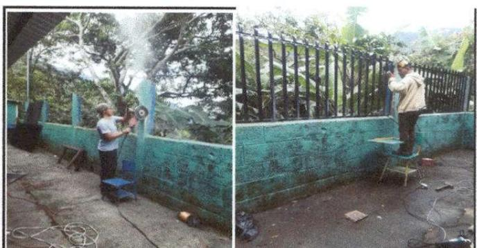
Foto 6: Malla dañada, se quiere sustituir por balcones de metal (largo 27.50 mts y alto 11 mts.
